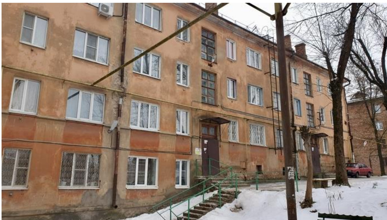
На фото: г. Великие Луки, пр. Гагарина, д. 54 (до капитального ремонта фасада)
