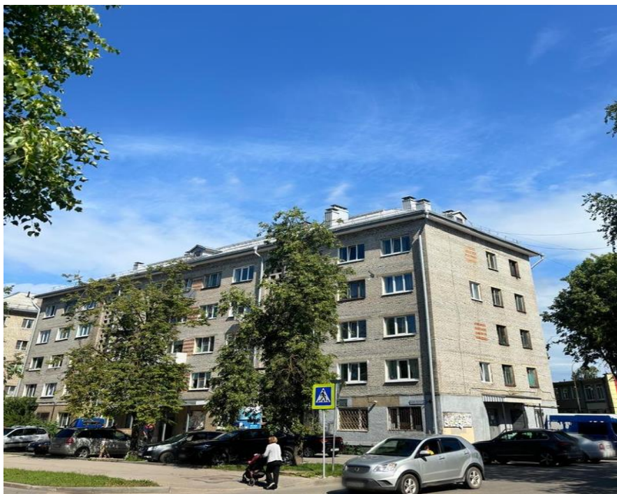
Фото 7 – г. Псков, ул. Льва Толстого, д. 20Б (капитальный ремонт крыши)
