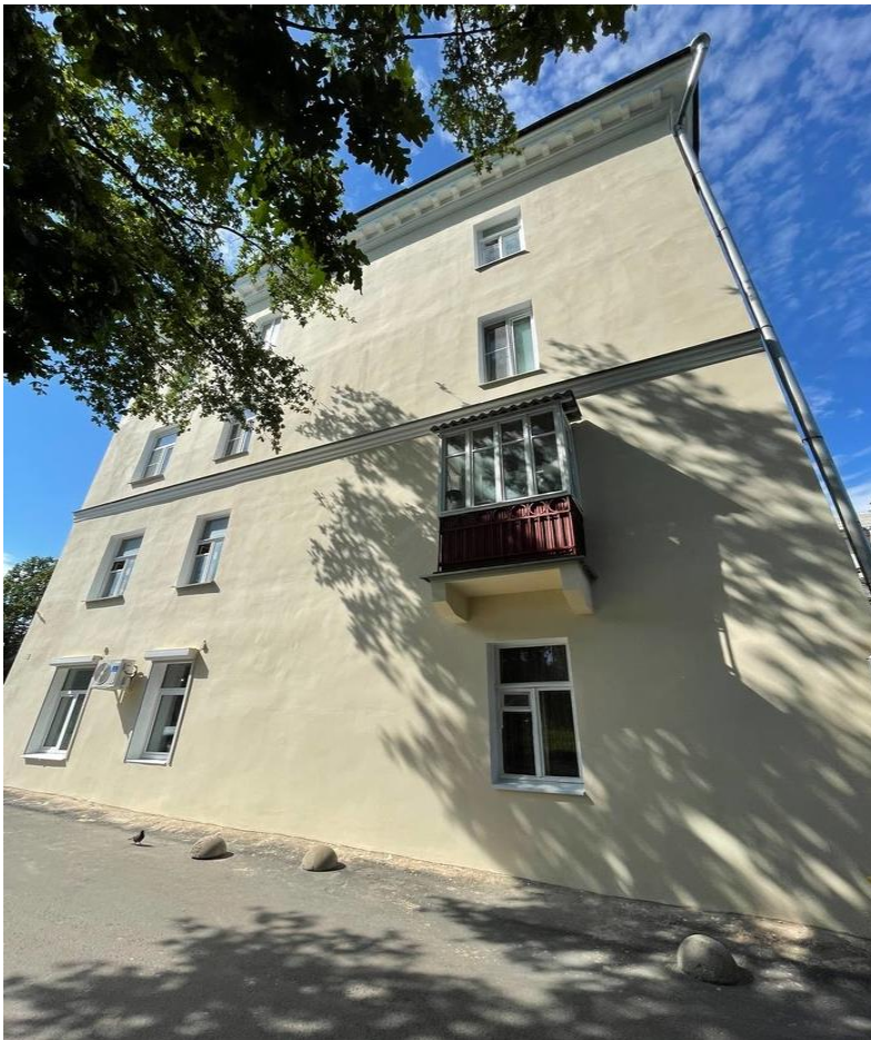
Фото 10 – г. Псков, ул. Байкова, д. 4 (капитальный ремонт крыши)
