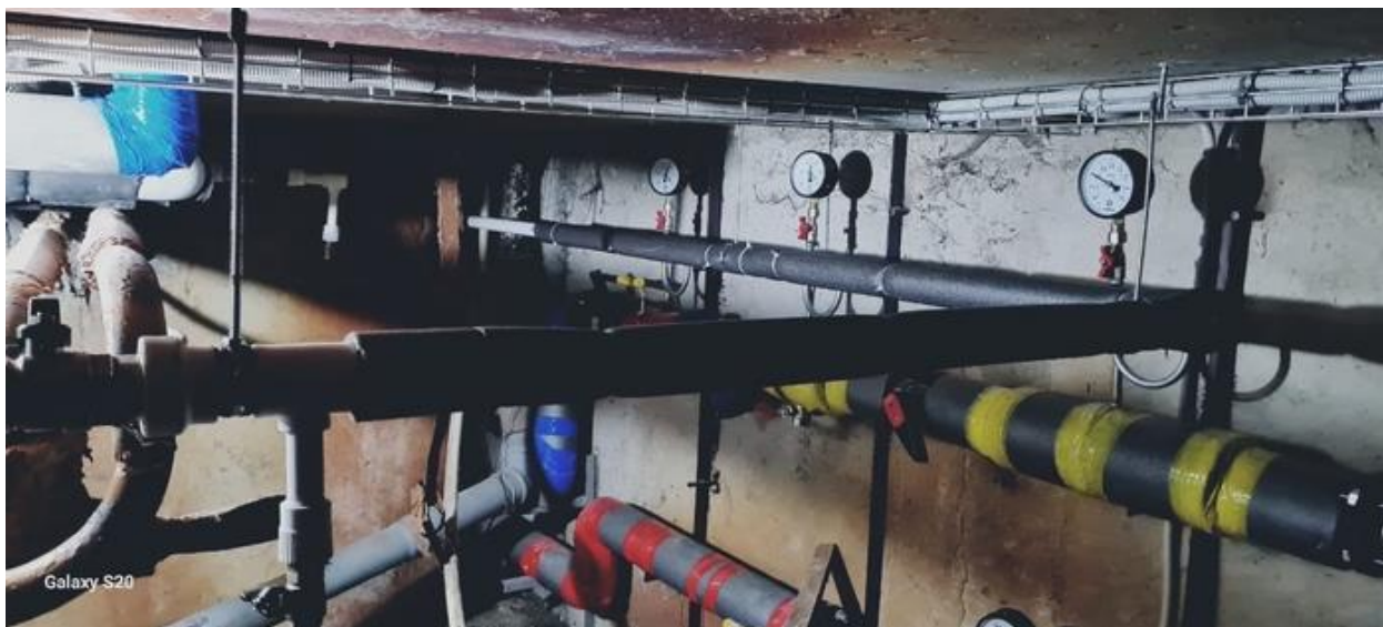
Фото 4 – г. Псков, ул. Николая Васильева, д. 73А (капитальный ремонт холодного и горячего водоснабжения и водоотведения)
