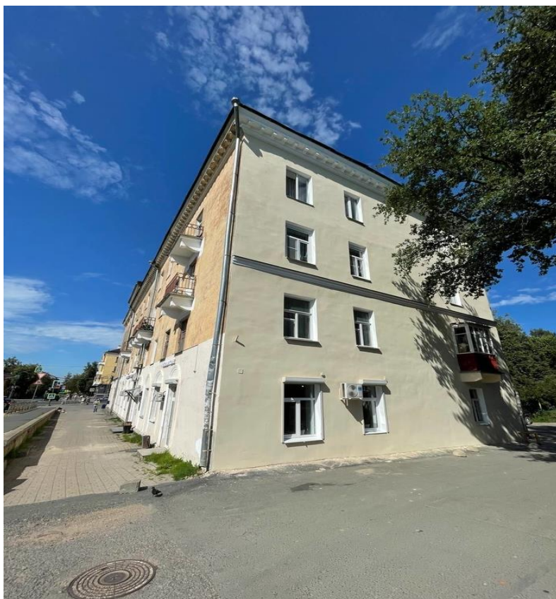
Фото 9 – г. Псков, дом №14/6 по ул. Максима Горького (капитальный ремонт фасада)
