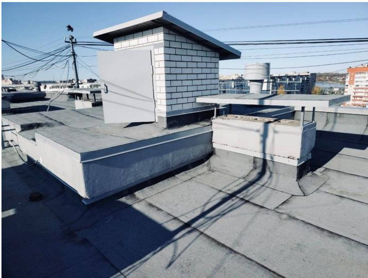
Фото 17 – г. Псков, ул. Коммунальная, д. 44 (капитальный ремонт крыши)
