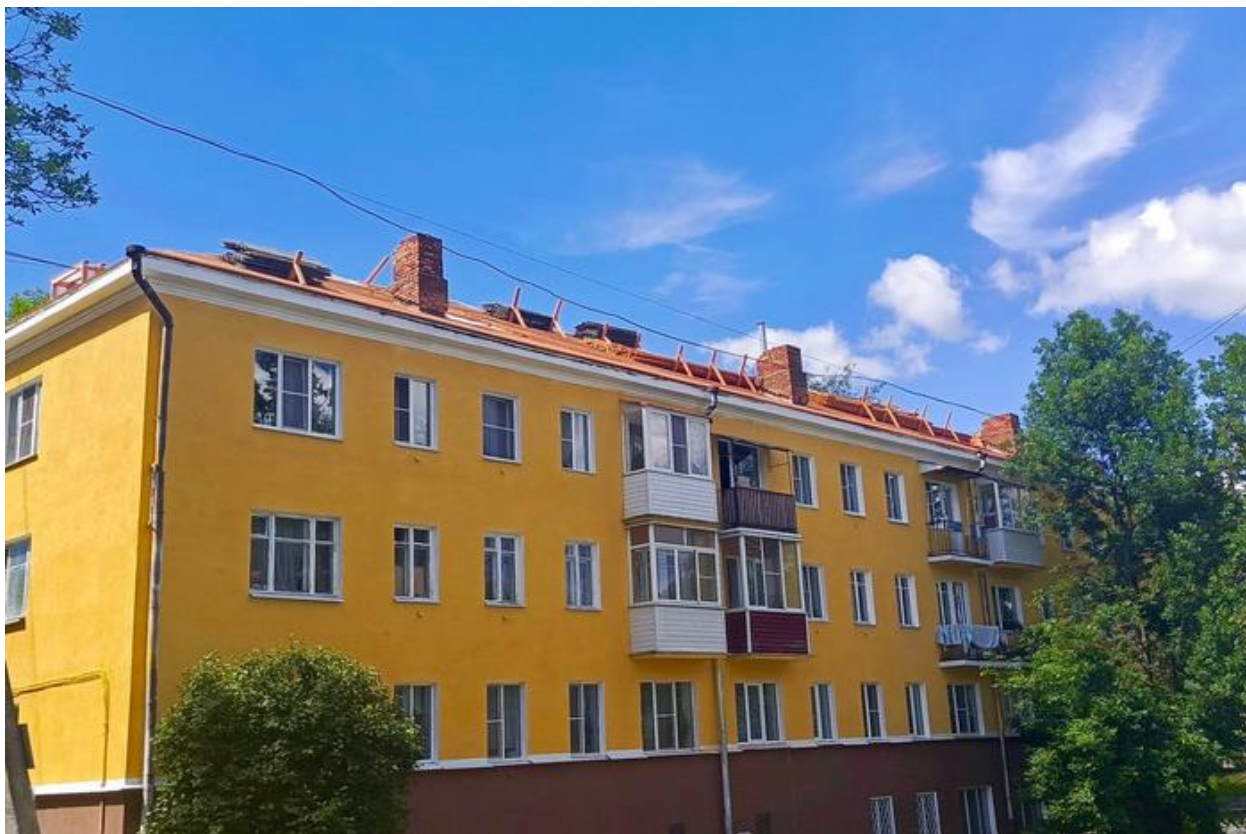
Фото 8 – г. Великие Луки, пр. Гагарина, д. 54 (капитальный ремонт фасада)
