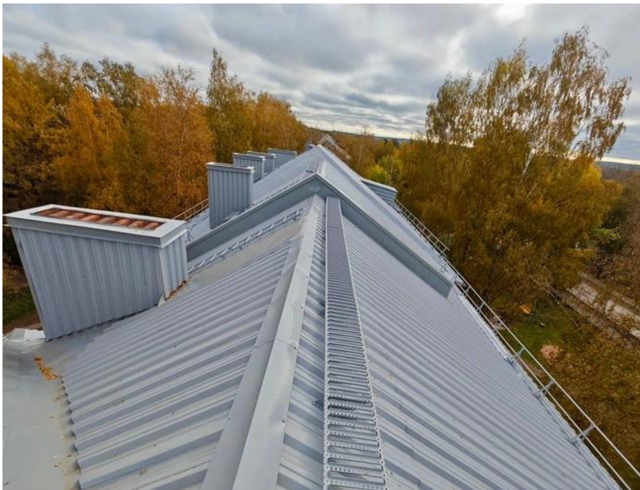
Фото 16 – г. Остров-3, д. 2 (капитальный ремонт крыши)
