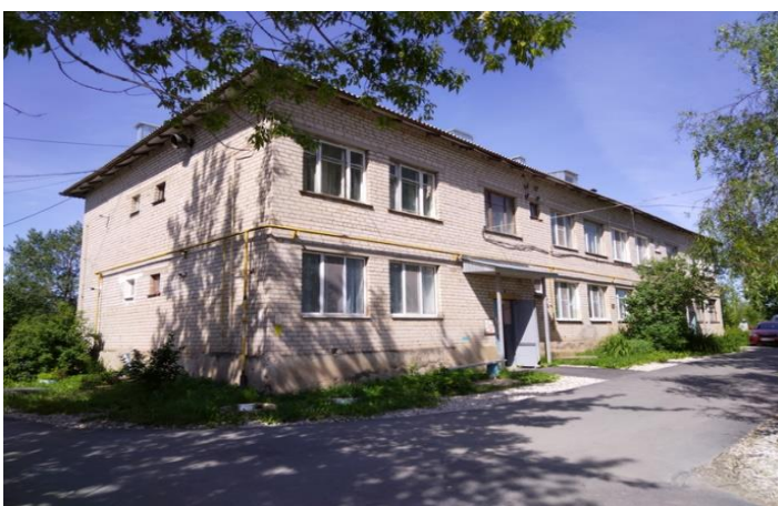
На фото: рп. Палкино, ул. Псковская, д. 11 (после и до капитального ремонта фасада)
