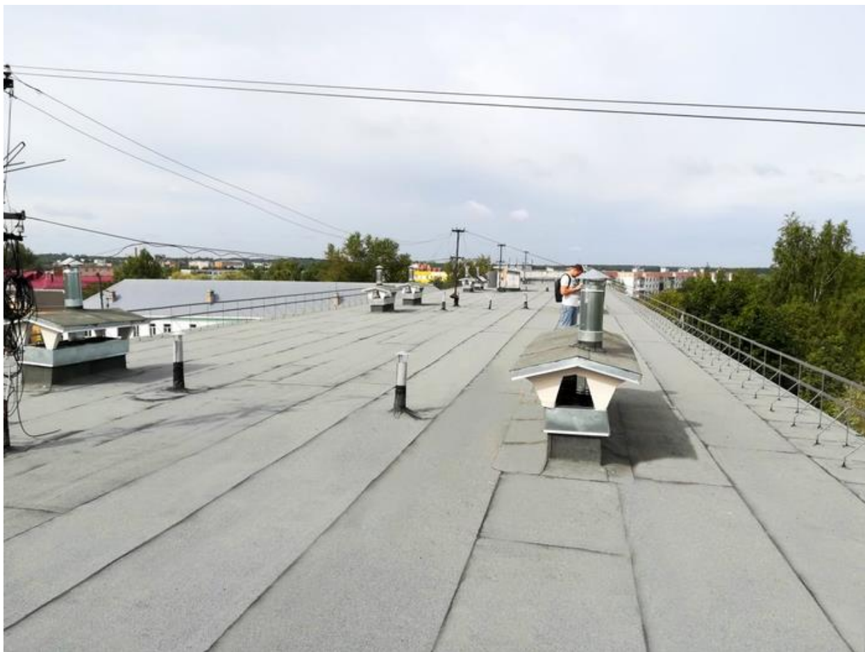
Фото 12 – г. Остров, дом №2 по ул. Островских Молодогвардейцев (капитальный ремонт крыши)
