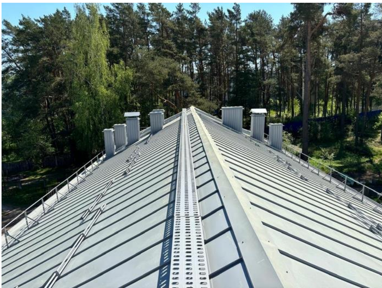
Фото 5 – г. Псков, ул. Санаторная, д. 1 (капитальный ремонт крыши)
