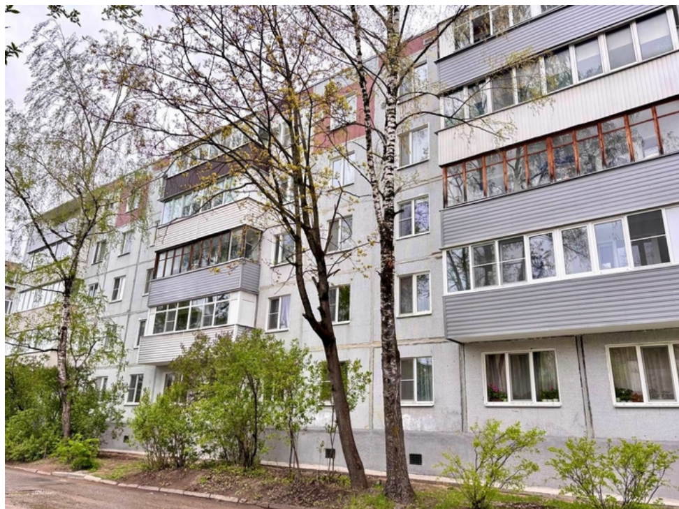
Фото 5 –дом по адресу: г. Псков, г. Псков, б-р, Сиреневый, д. 7 (до и после капитального ремонта крыши и фасада)
