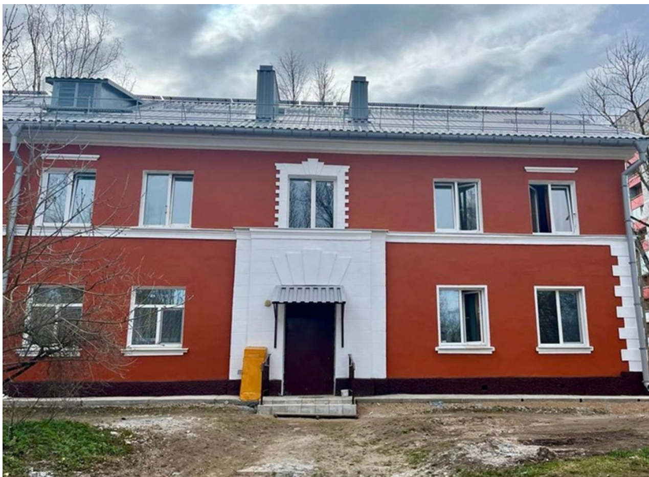
Фото 4 –дома по адресам: г. Великие Луки, - ул. Новоселенинская д. 30/1; - ул. Ставского д. 73А; - ул. Герцена 5/23. (до и после капитального ремонта фасада)
