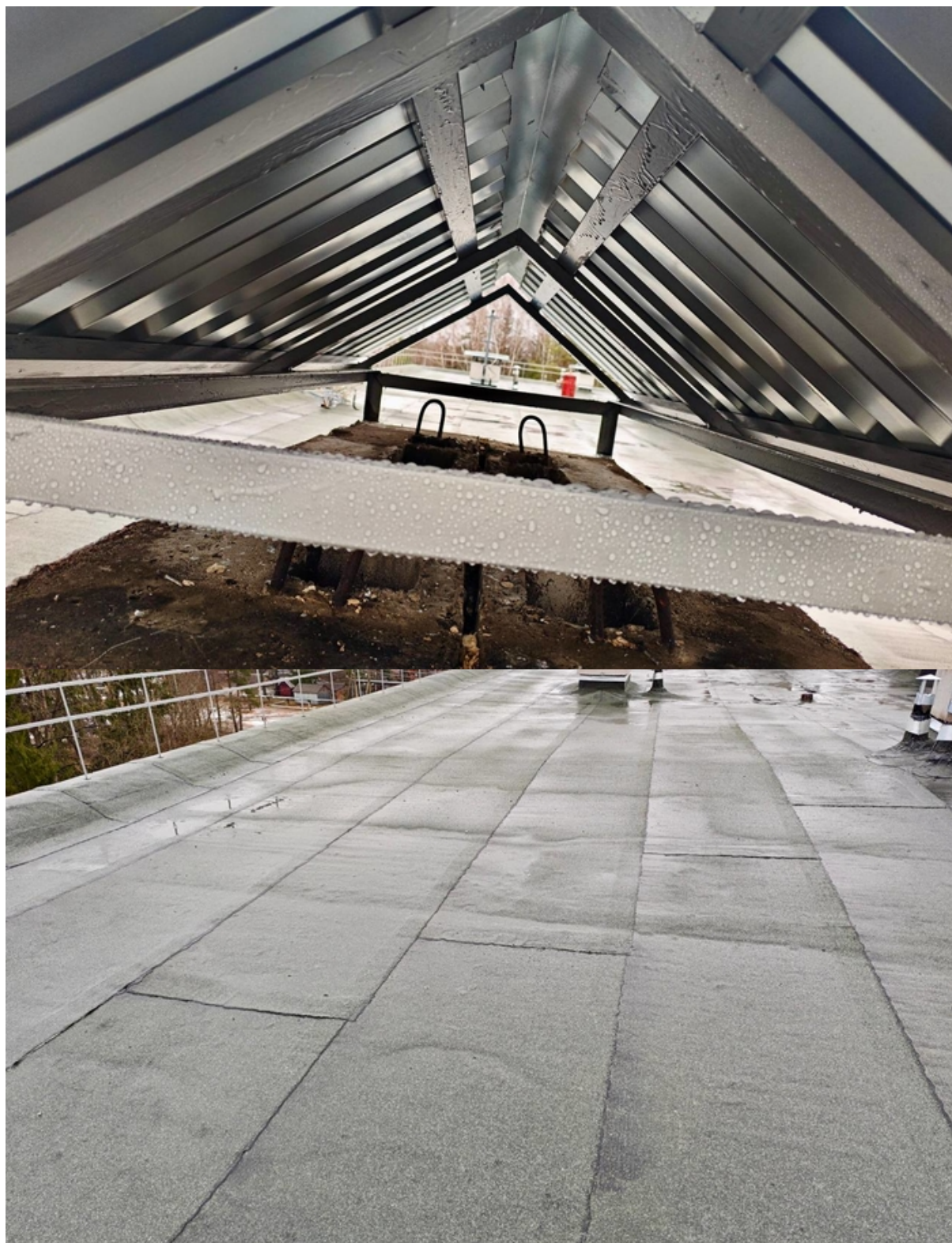
Фото 2 –дом по адресу: Псковский р-н, д. Соловы, д.8 (капитальный ремонт крыши)
