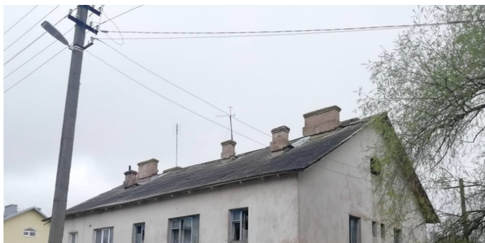
Фото 12 –дом по адресу: д. Лющик, ул. Октябрьская, д. 5 (до и после капитального ремонта крыши)
