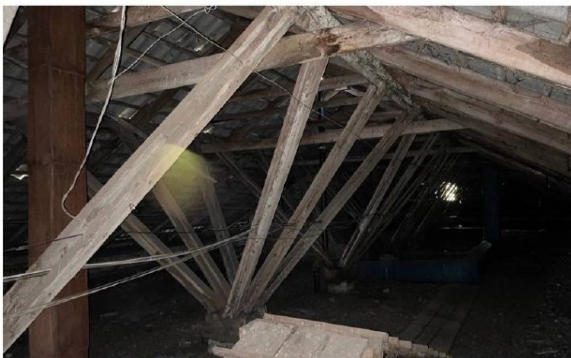
На фото: до и после капитального ремонта крыши
