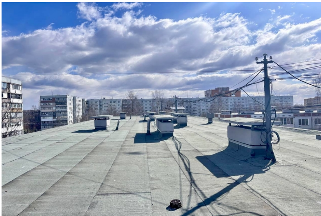
Фото 3 –дом по адресу: г. Псков, б-р Сиреневый, д.13 (после и до капитального ремонта крыши)
