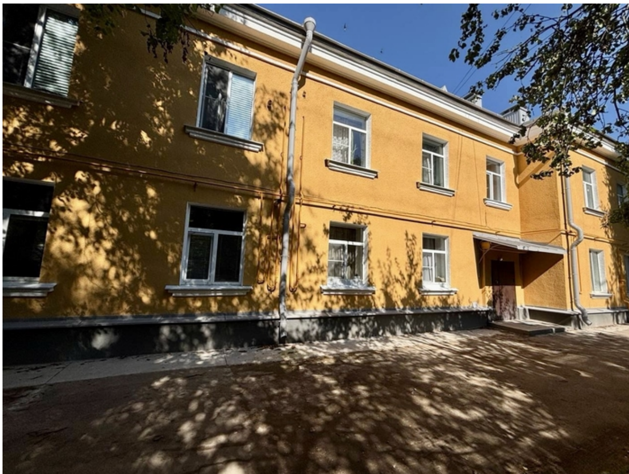
Фото 10 –дом по адресу: г. Псков, ул. Металлистов д. 32 капитальный ремонт фасада и крыши
